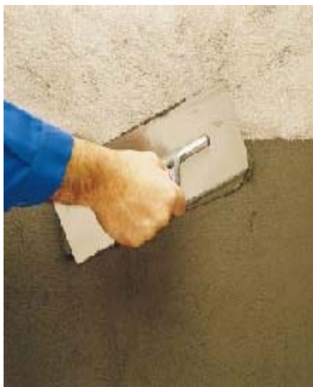
нанесение шпателем
