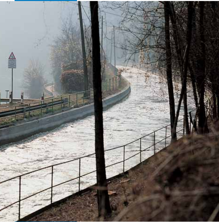
Подводящий канал ГЭС в г. Бертини – Ровьяте (Область Комо) с поверхностью, обработанной Idrosilex Pronto
