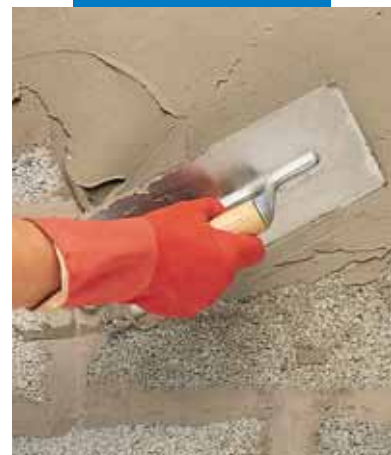
Нанесение Idrosilex Pronto мастерком
